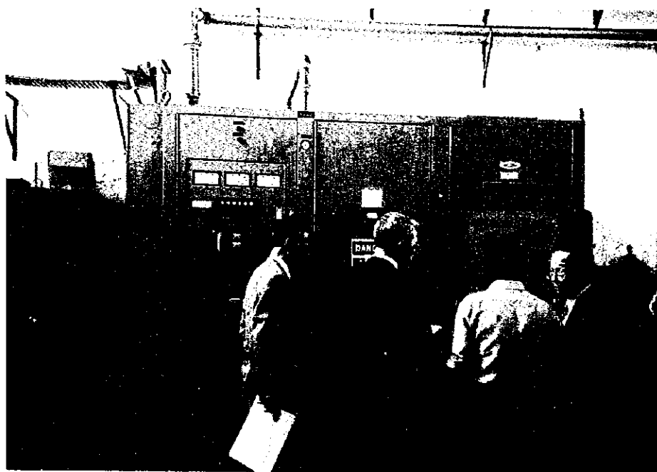
サイト調査 (高周波誘導炉 パネル前)
