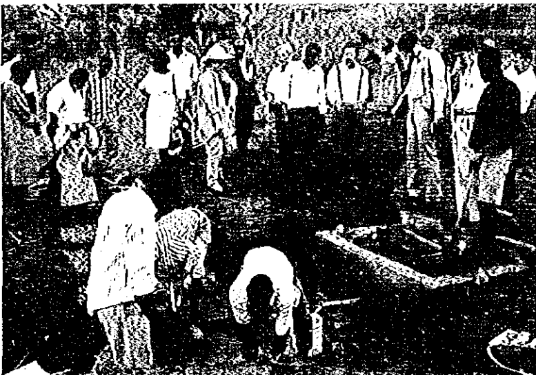
湧水利用の簡易井戸設置作業
