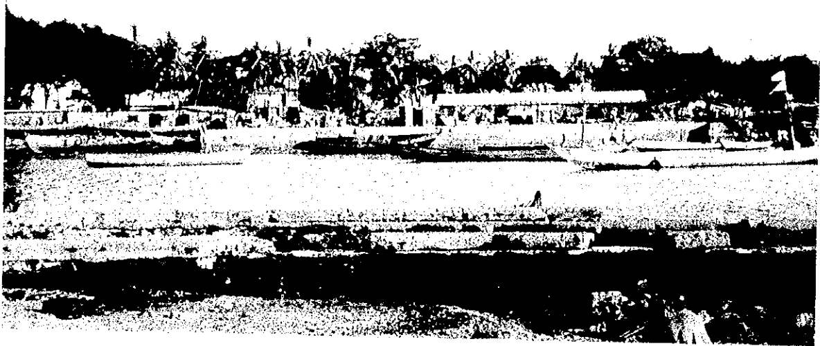
運搬船用斜路側より既存ブルビネ水揚場を望む
