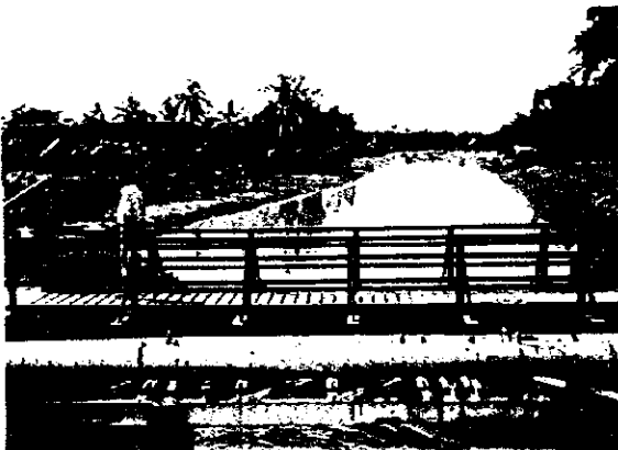
Sg. Lerch 下流部流路を下流側より上流を望む
