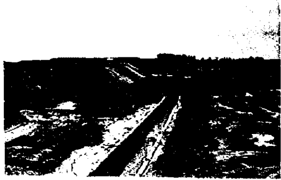
工業団地の造成状況
