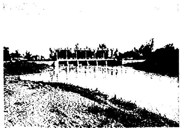
Sg. Malim 河口部の潮止め堰を上流側より望む
