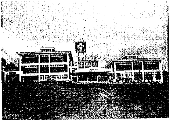
(写真42) 正面外観： 新築3階建て施設，給水がまだ接続してない。
