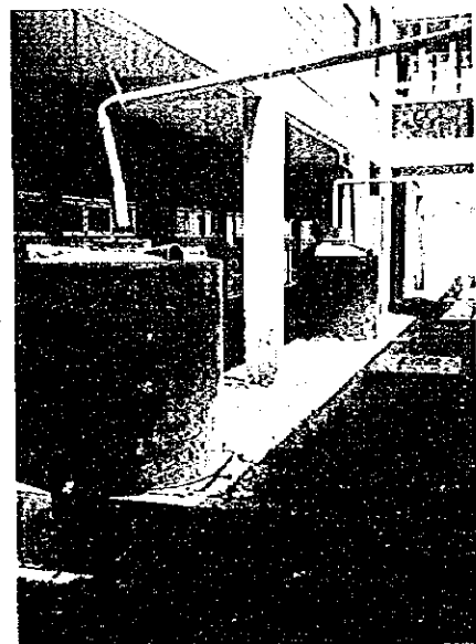
(写真47) 雨水槽： DANIOA仕様(2基)が唯一の給水源。
