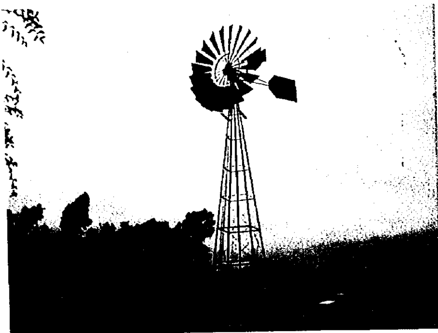
農村工業開発センター 風力発電施設
