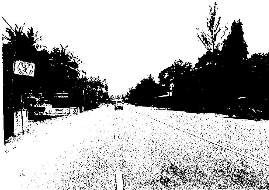
写真-16 計画路線と国道A-8号線との交差点付近の状況
