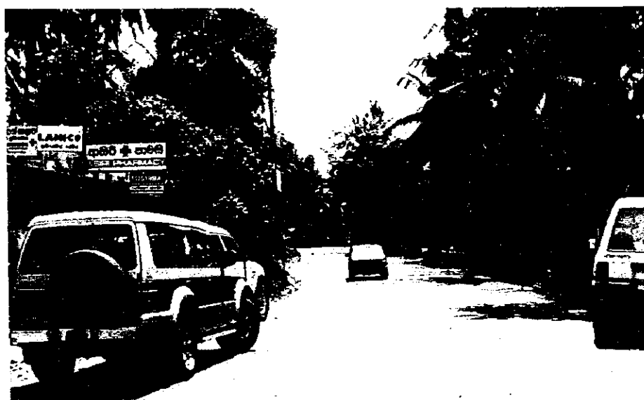
写真-7 計画道路と国道 B-435 号線との交差点付近
