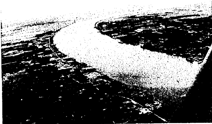
写真-14 上空より、Alignment A Rupsa 橋 (河幅550m) 架地予定 地点を望む。右側がクルナ市。
