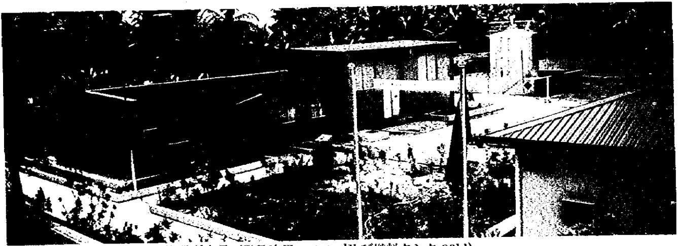
発電所全景 (発電建屋 247.5㎡及び燃料タンク 80kl)
