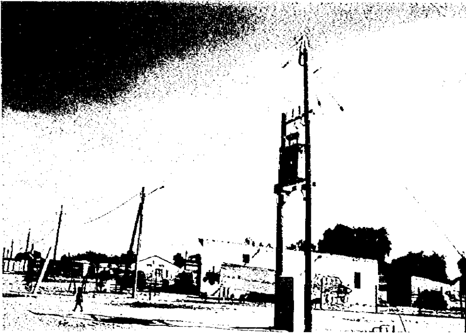
11kV Line (Ondangwa)
