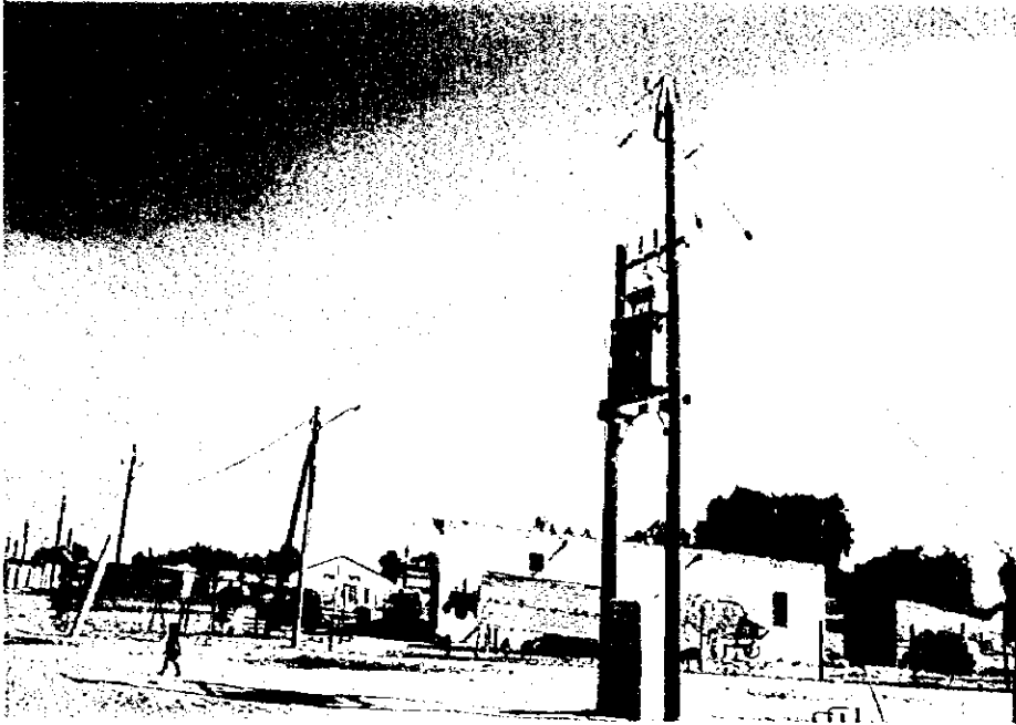
11kV Line (Ondangwa)
