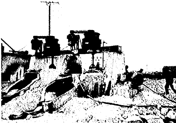
図4-1-5 製砂機 投入作業
