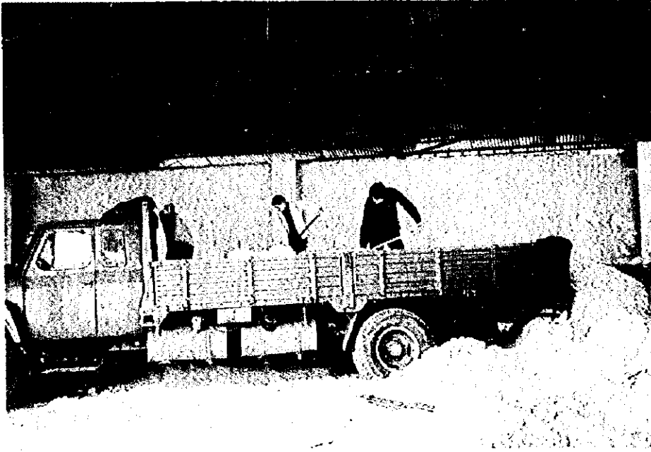
図4-1-2 珪砂の 荷下ろし
