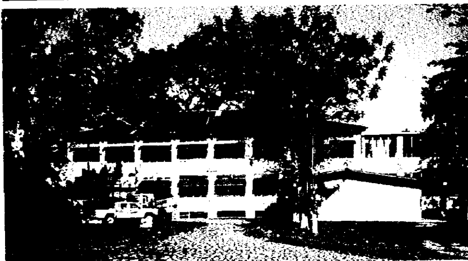
F.改修対象施設 (食堂棟)
