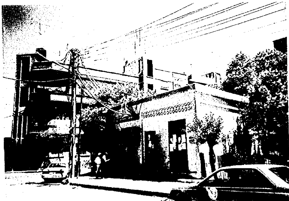
20/0.4kV 変圧器室
