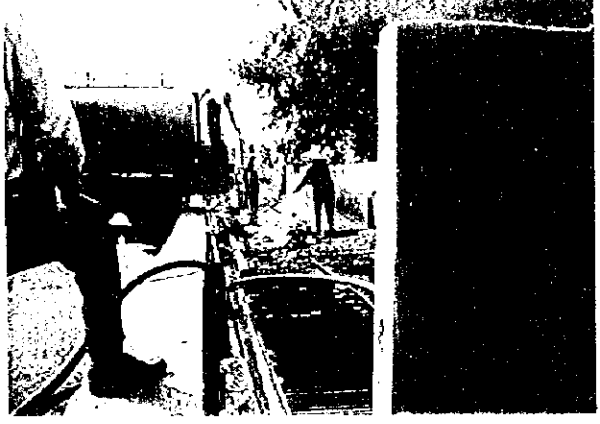
Onnutし尿処理施設のし尿(セプティックタンク汚泥)投入風景
