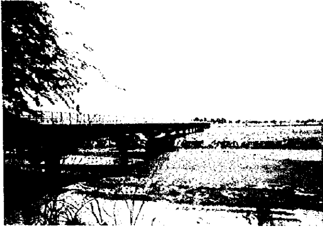
⑩バグバット～クンドリ橋 全景
