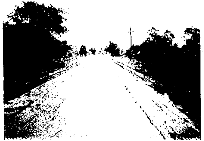
幅3mの地方道 (西マジョナランド州)
