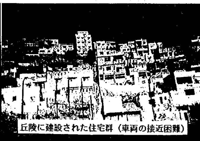
丘陵に建設された住宅群（車両の接近困難）
