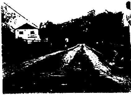
路面のたわみが著しい (ナルトゥバナ橋)
