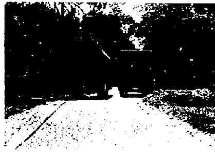
狭いアプローチ道路 (モダ・エラ橋付近)
