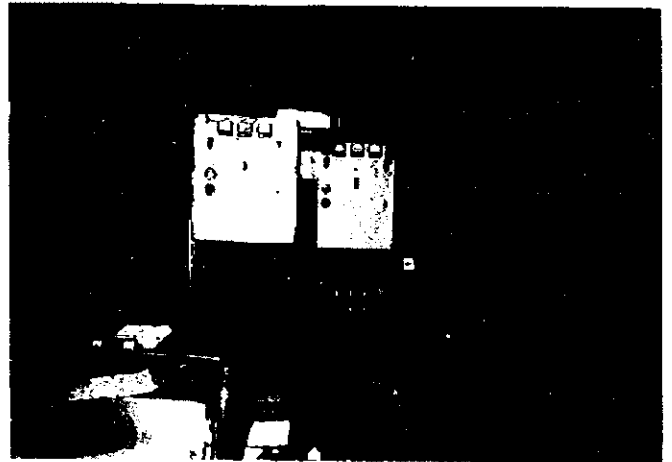
コントロールパネル
