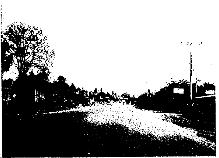
国道13号、水準測量及びトランス測量路線になっている。
