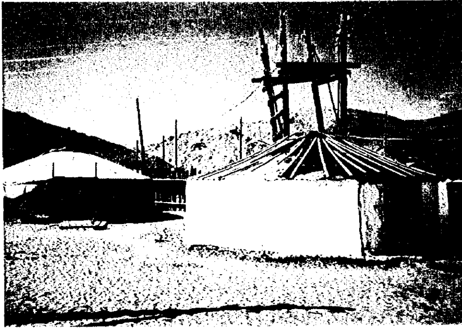
配電線立上りと運転員詰所（タリアト・ソム）
