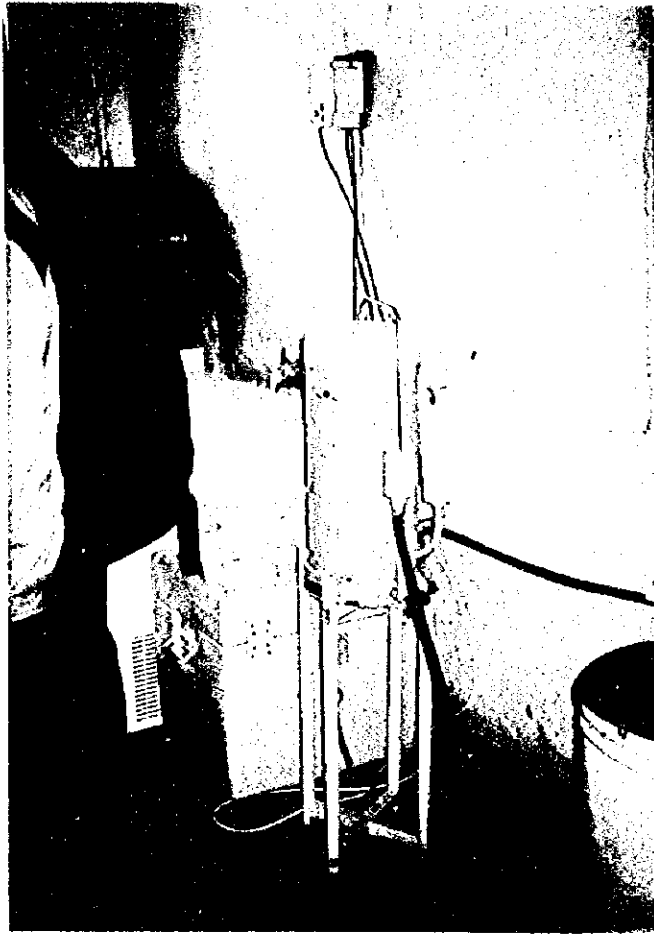
蒸留水精製機 (3kVA) (ルン・ソム病院)
