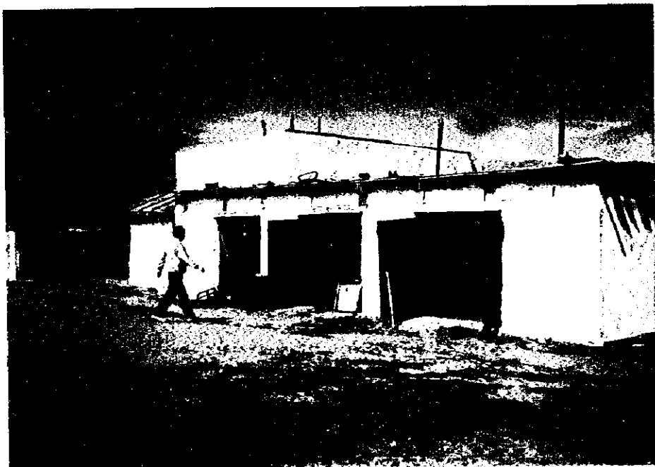
ディーゼル発電所建屋 (タリアト・ソム)
