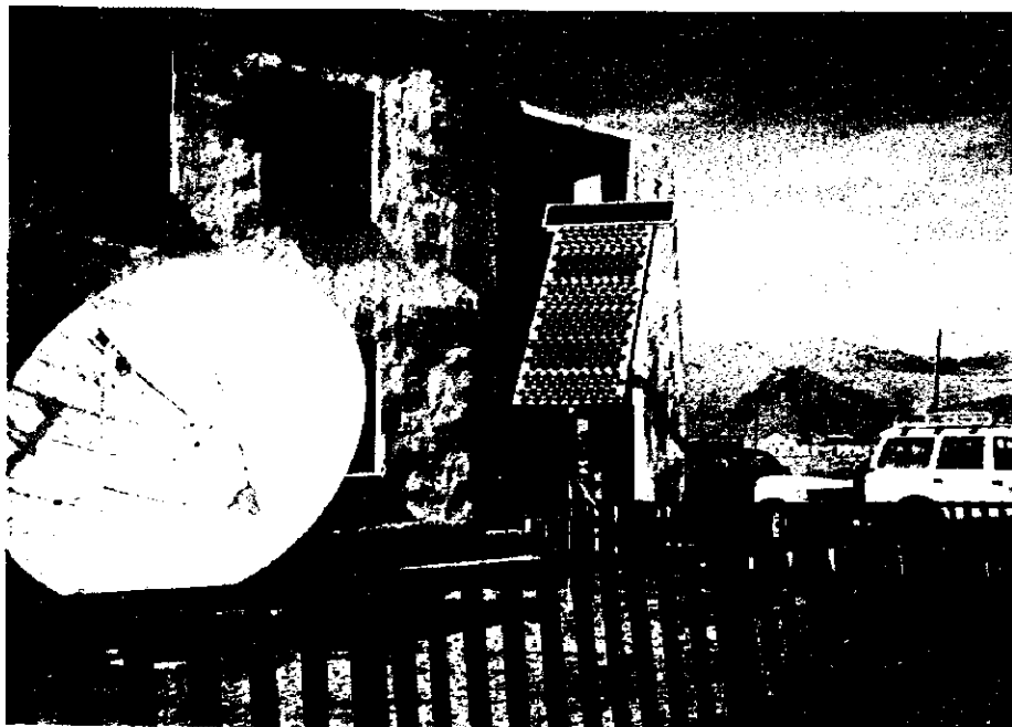
PVパネル (210W) とパラボラ・アンテナ (タリアト・ソム通信所)
