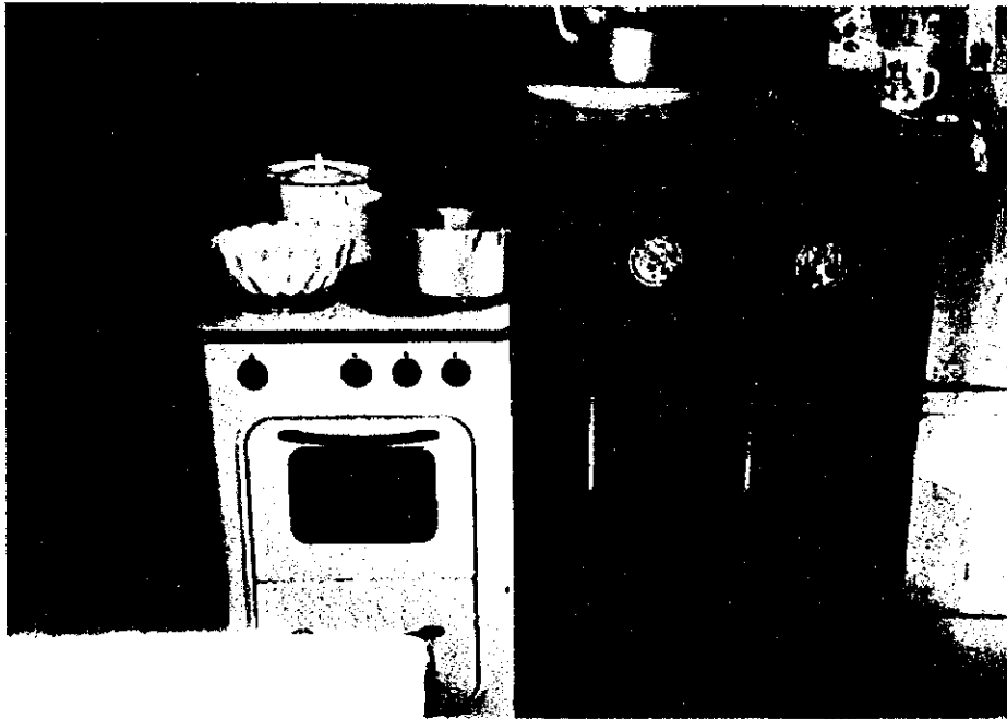
加熱消毒用電気コンロ (1.2kW×3口+オーブン) (チョロート・ソム病院)
