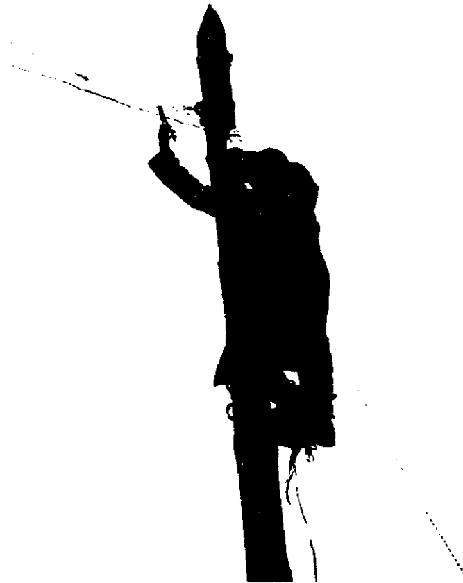
配電工事風景 (フレンボイル・ソム)
