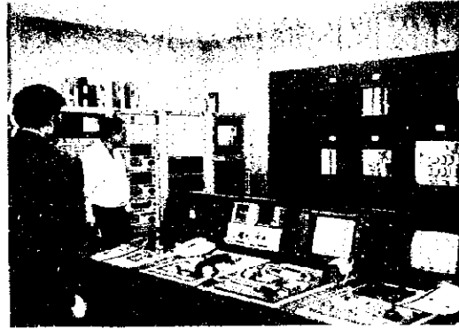
▲供与機材の設置、使用状況
