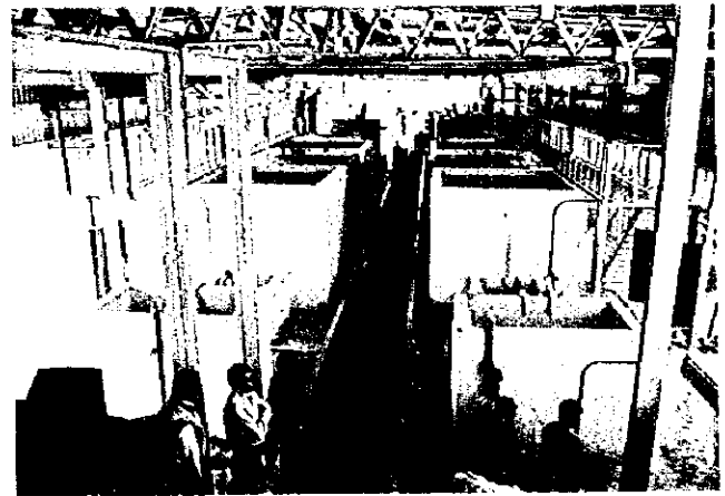
塩分濃度の高い地下水が浸出してくるため、物理化学処理が行われている。
