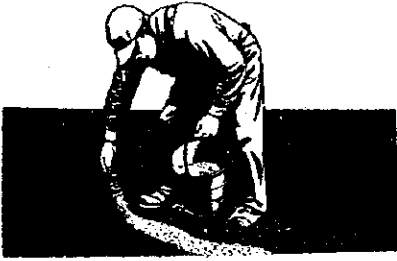
Şekil — 28. Çatlakların tedavisinde kullanılan sırtı arda't üzerine kuru kum serpilmesi.
