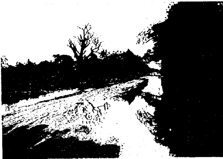
既存ロアーモシ プロジェクト地区内 のトランクロードの 排水不良状況 (チェケレニ村付 近)
