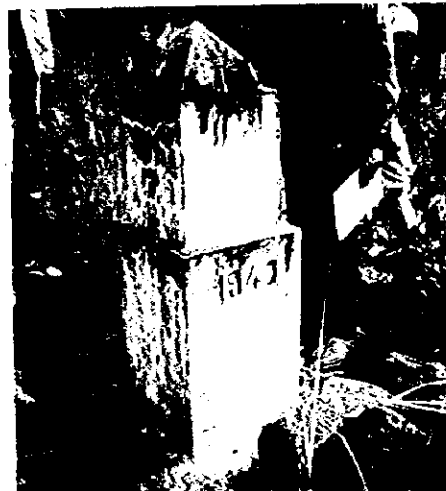
写真-4 植民地時代に、ポルトガルによって設置された三角点(リシंगा市北北東方約100km;旧基線端点で、道路近くの平らなところにある)。この点は、ノルウェーの技術協力によるGPS新基準点設置の一環の1点としても使われ、最近、成果が算出された。
