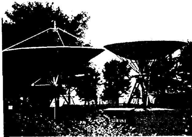
商業テレビ放送局(SCTV スラバヤ) 番組衛星伝送用パラボラアンテナ
