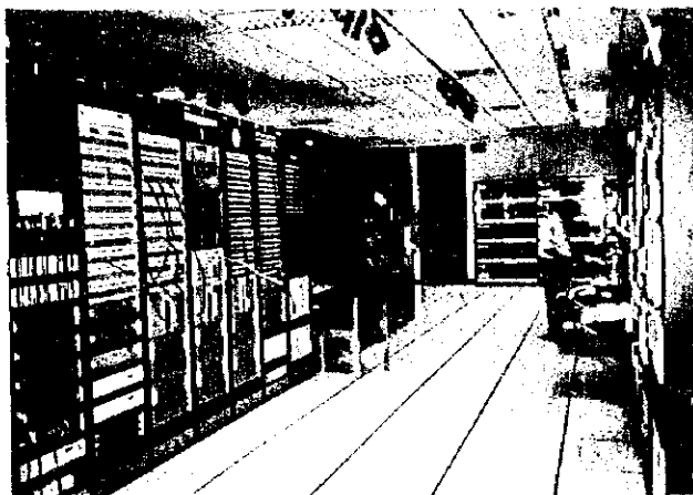
商業テレビ放送局(SCTV スラバヤ) 主幹機置機器室
