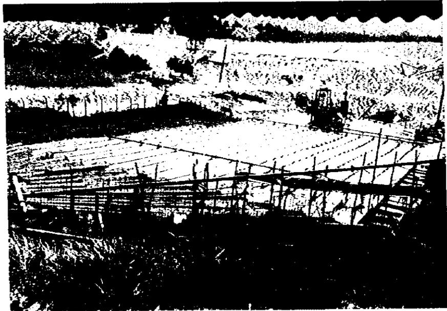
写真-12 稼行中の砂錫鉱山の粗選場 (猫ながし)
