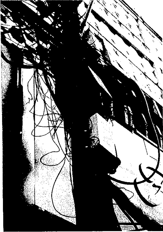
加入者ケーブル（電柱部）
