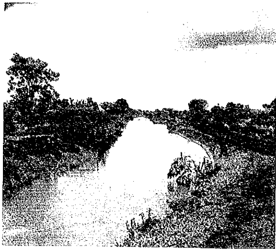
テイバ川幹線用水路
