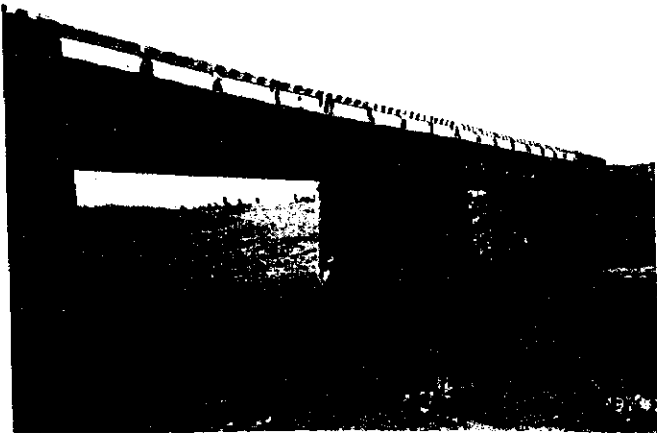
B-013 2径間RC-T桁橋(1994年建設) 異常は認められない。
