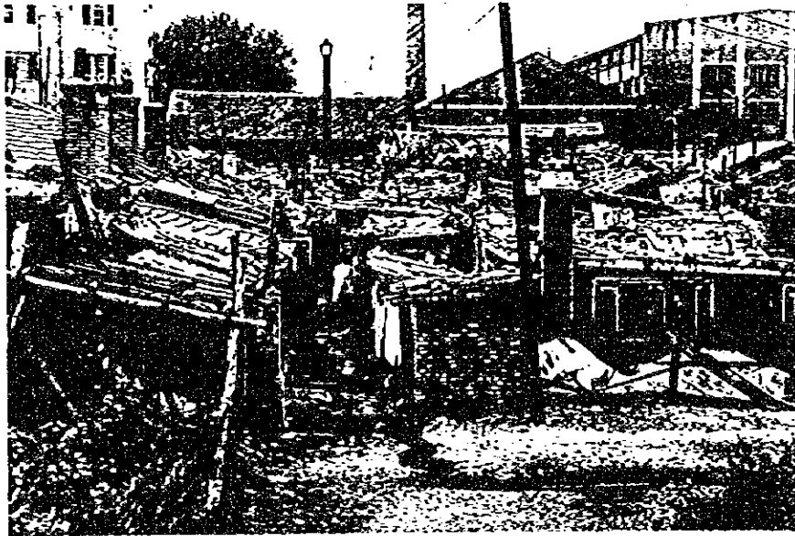
図7-2-13 寛城052地区の不良住宅群
