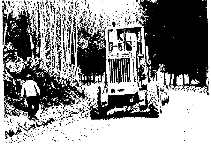
道路補修現場（クエンカ近郊） 使用機材：モータグレーダ・振動ローラ・散水車
