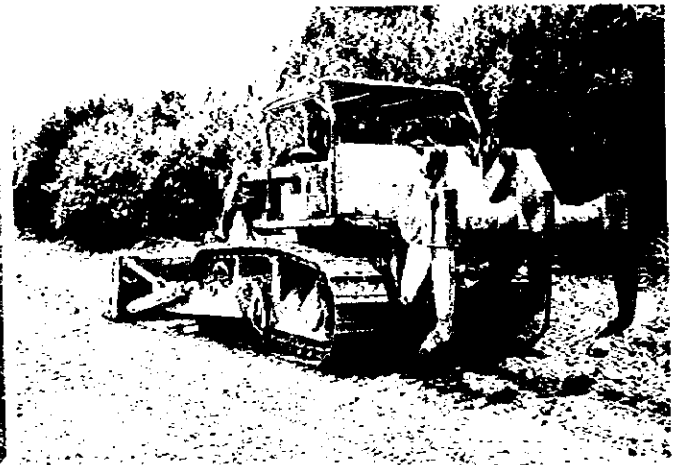
道路整備作業現場（シャガール） ブルドーザによる土工作業
