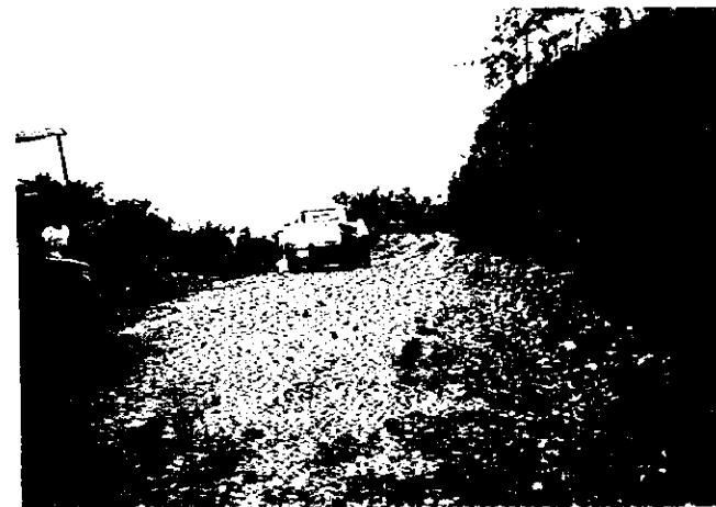
シュミラル近くの道路整備現場
