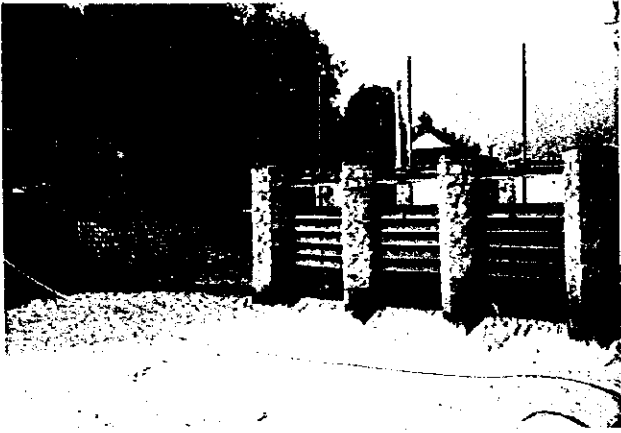
マイボ川オブラ取水工：農業・発電用水を取水、都市用水は対岸で取水している。
