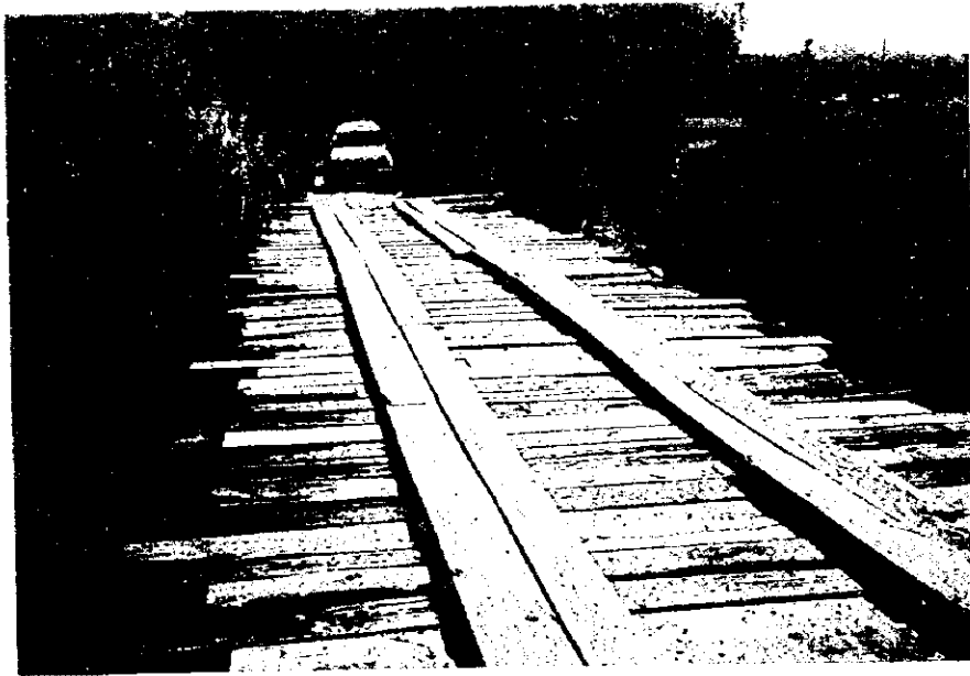
付け替え予定の橋
