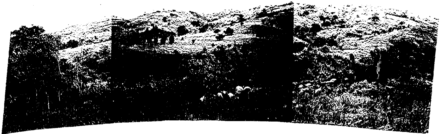
ダムサイト左岸から右岸の眺望
