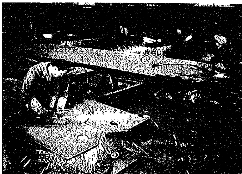
図4-2-3 手動ガス切断機による切断作業
