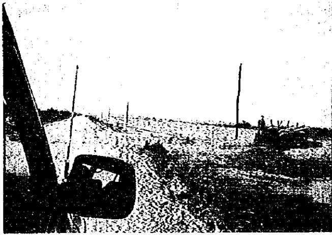
日ボ協会が掘削した排水路 (現在下流域の住民からクレームが出され工事中止)
