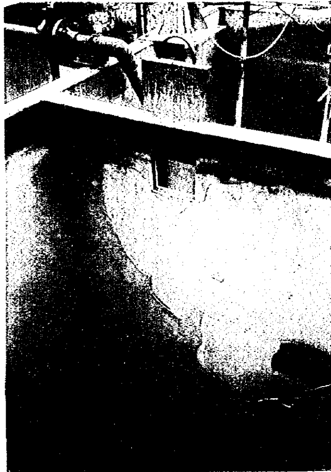
写真-14 一次中和槽 (VE-03B) 側壁についた石膏 部分的に剝離する (厚さ 5~10mm)
