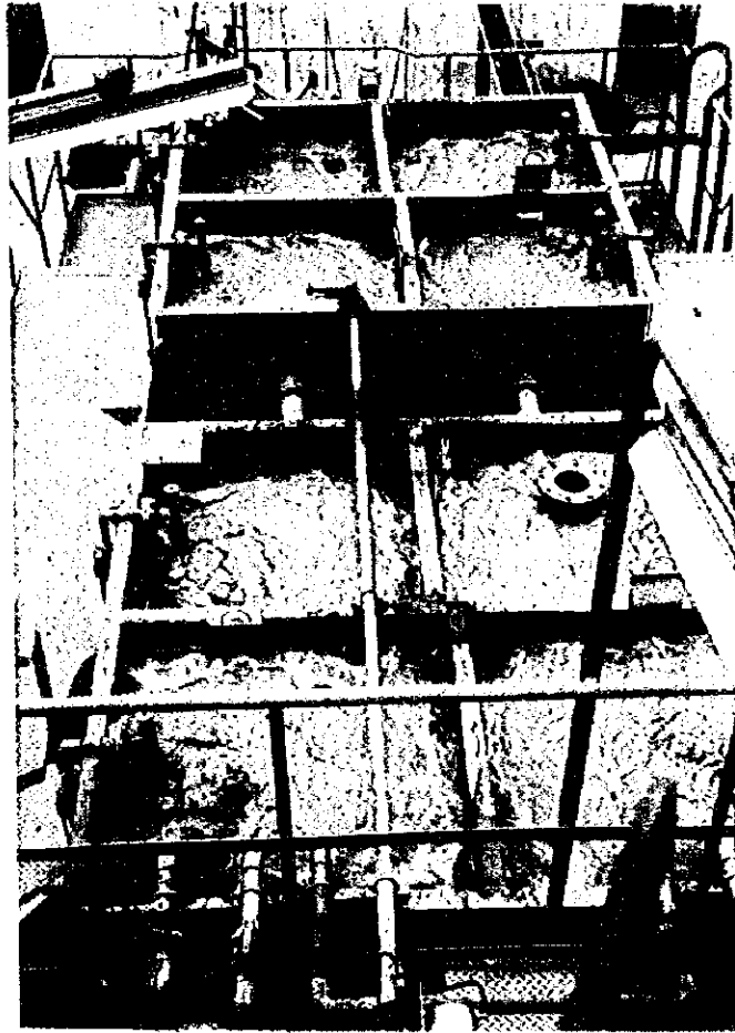
写真-3 廃水配管と一次中和槽
