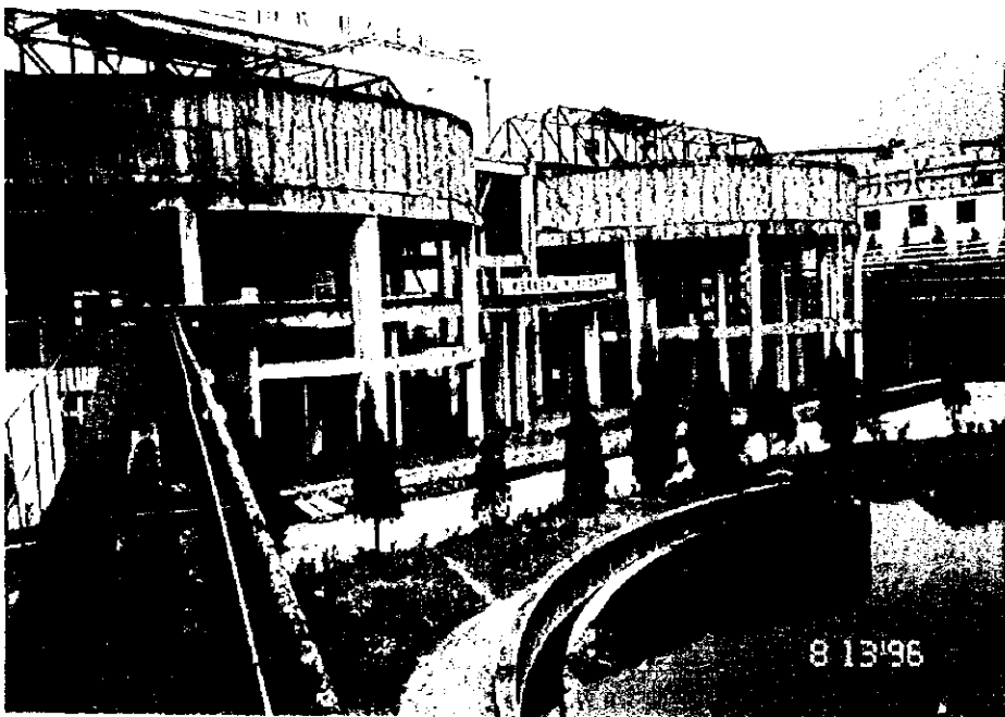
写真-8 高架の中和槽と沈殿池
