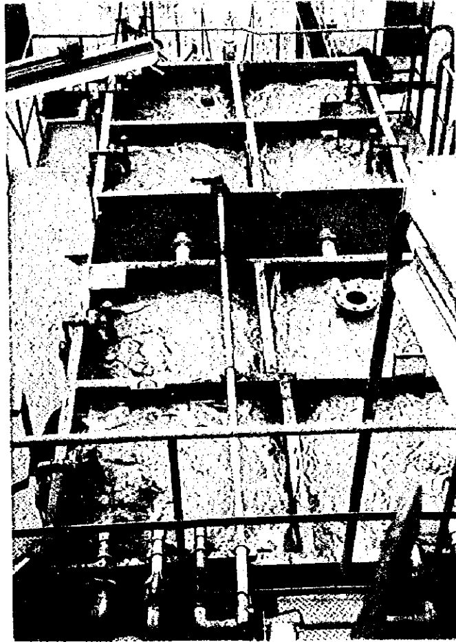
写真-3 廃水配管と一次中和槽
