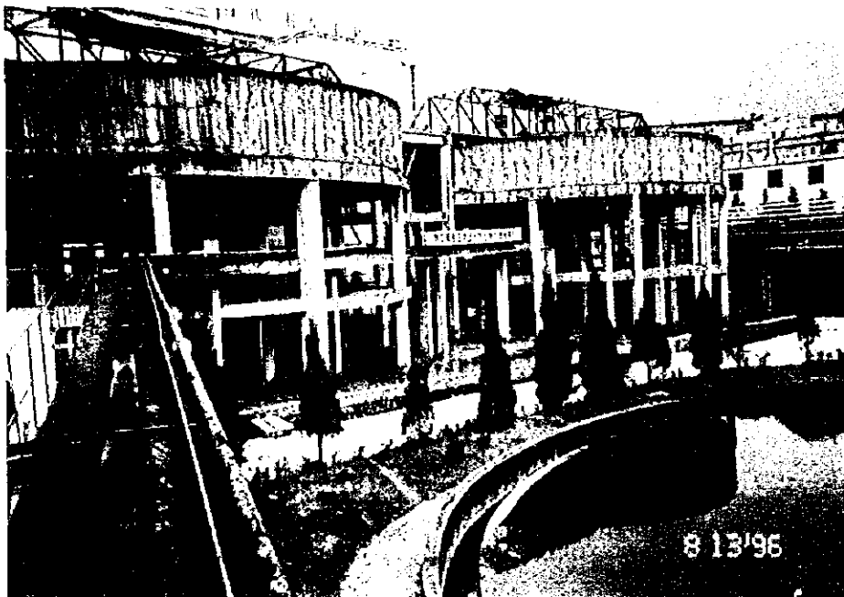
写真-8 高架の中和槽と沈殿池
