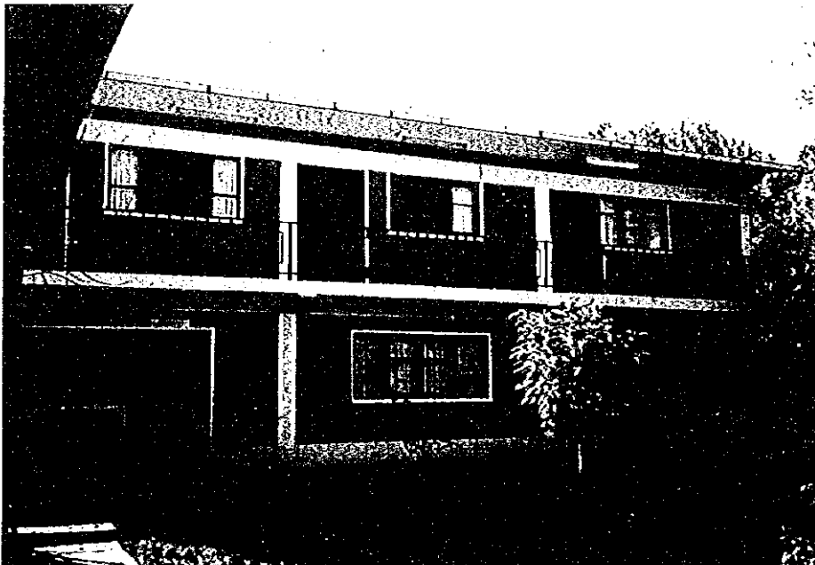
タリハ市にあるPERTT (タリハ県土地復旧 計画事務所) * 所長室及び専門家 が使用する予定の 部屋がある建物
