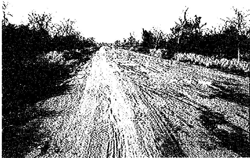
写真 3 - 12 M10の路面状況
