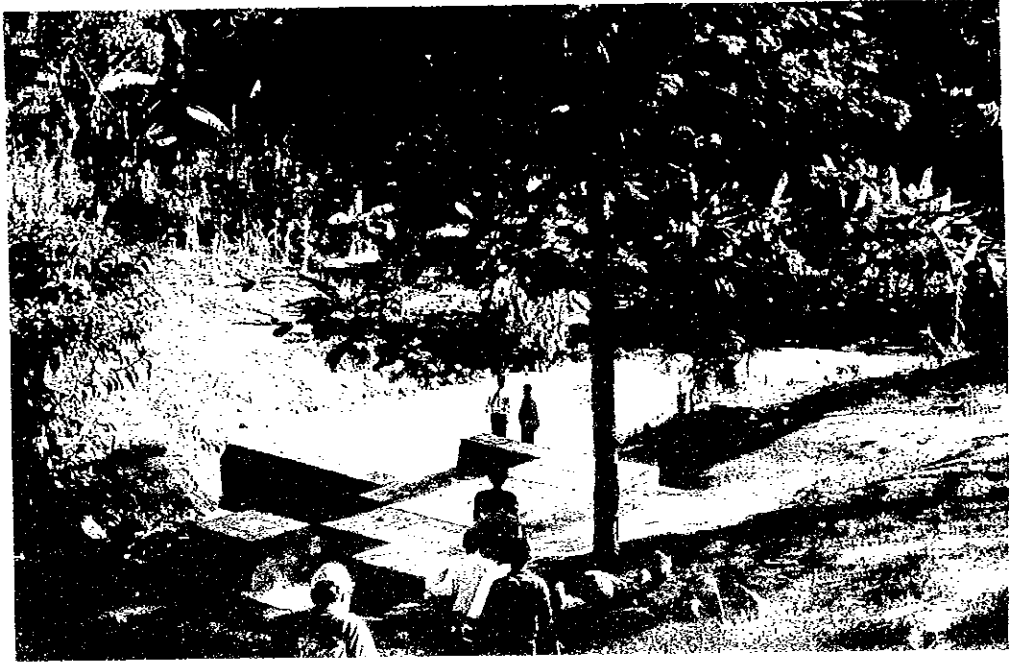
SISDOの融資により建設された頭首工
