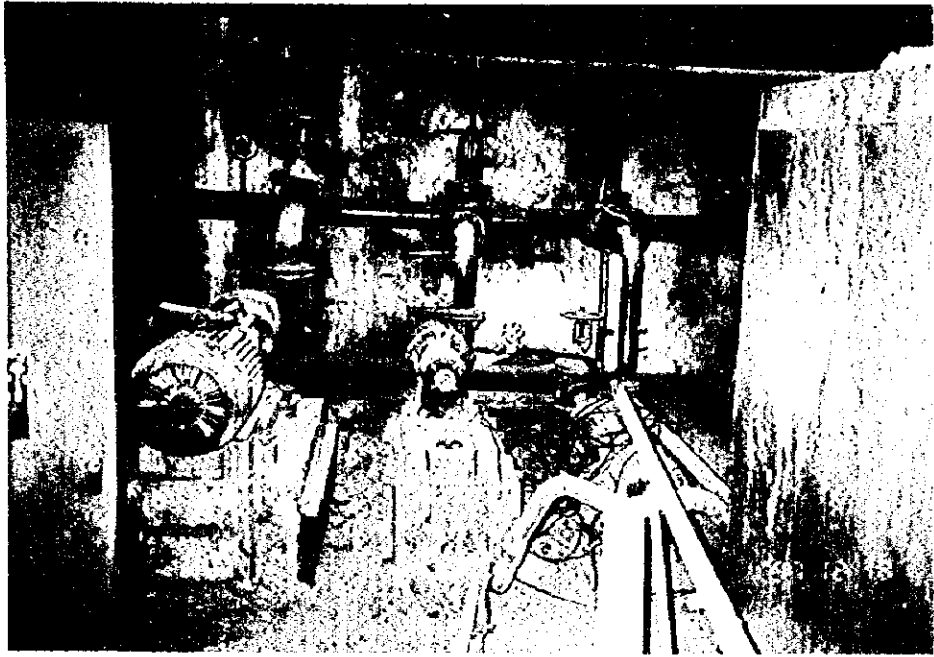
熱水循環ポンプ
