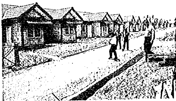
4. パルンパンジャン1工区（第1期建設完了） （予備調査）
