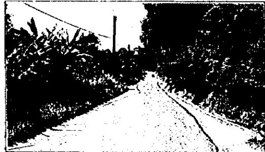
STA2+000 舗装状況、普通
