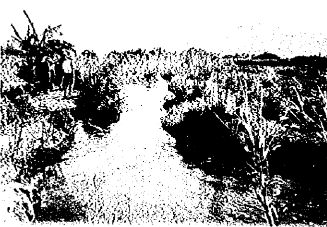
マロロ頭首工-A上流側（堆砂のため天井河川化）
