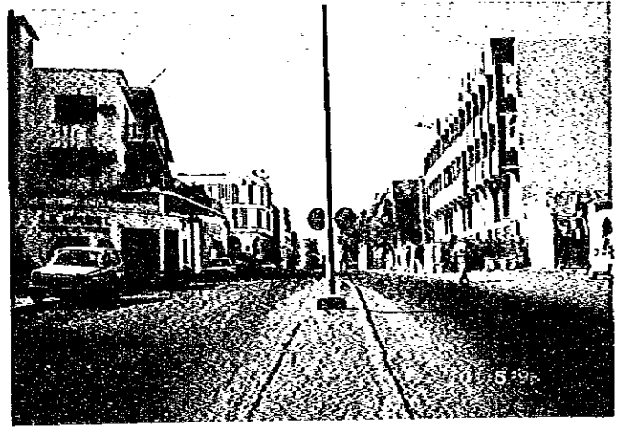
Vue à PK1,6
